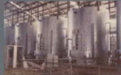
งานติดตั้งฉนวนกันความร้อน - เย็น และป้องกันเสียง THE INSTALLATION HOT - COLD AND NOISE INSULATION
