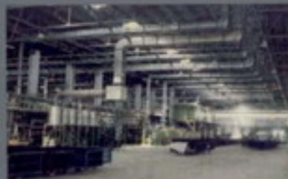
งานติดตั้งท่อลมปรับอากาศ และท่อดูดอากาศ THE INSTALLATION OF AIR DUCT AND EXHAUST SYSTEMS
